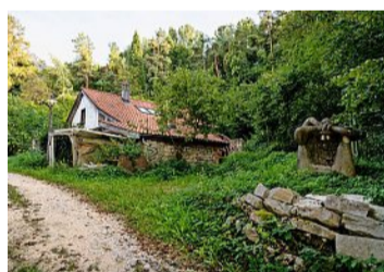
Das Haus im Paradiesgärtli wird renoviert.
